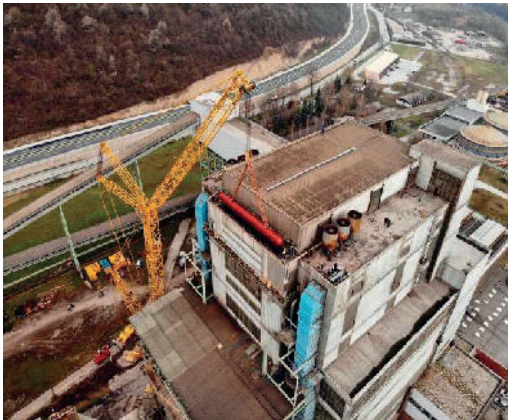
Slika 8. Montaža novog bubnja
