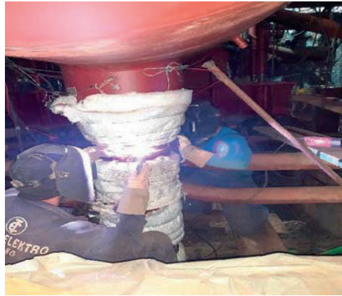
Slika 9. Zavarivanje bubnja sa spušnim cijevima
