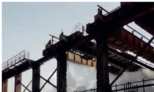
Slika 3. Prikaz stubova u liniji B kranske staze kod dopečne prerade troske
